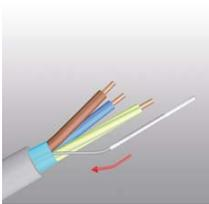
Kabel in der Gerätedose wie gewohnt abmanteln, dabei Folienschirm mit entfernen. Blanken Schirmbeidraht (SB) mit transparentem Isolierschlauch versehen (elektrisch isolieren) und 9–11 mm absolieren.
