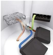
Bei geschirmten Gerätedosen keine ungeschirmten Kabel verwenden!
